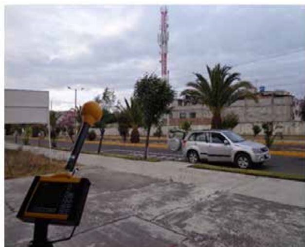
Fig. 1. Antena de Telefonía celular ubicada en el exterior de la ESPOCH
